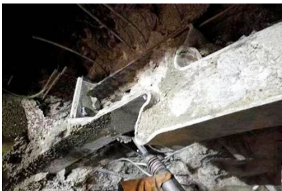
支护钢拱架严重变形
